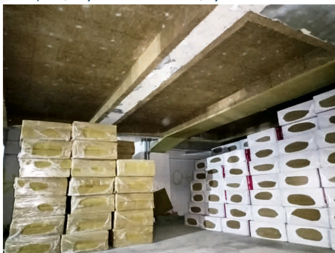
1. podzemní podlaží - protipožární obklad stropu
