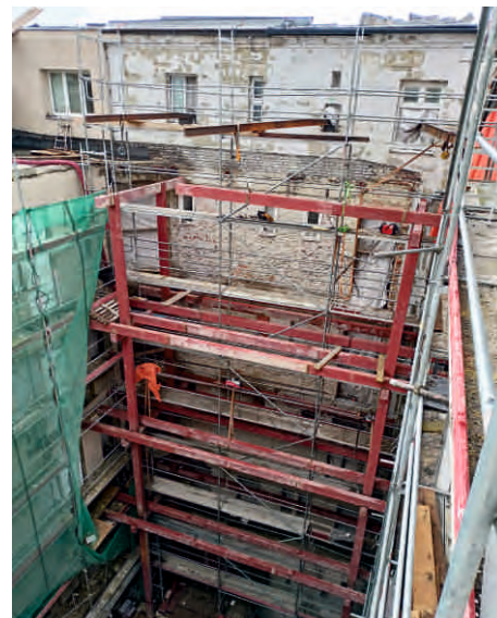
Ocelová konstrukce přístavby v "atriu"
