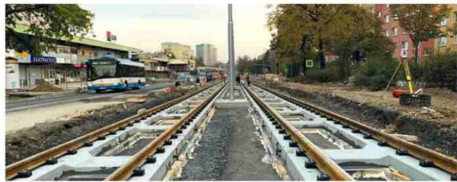
Koleje jsou uloženy na podélných nesoucích panelech
