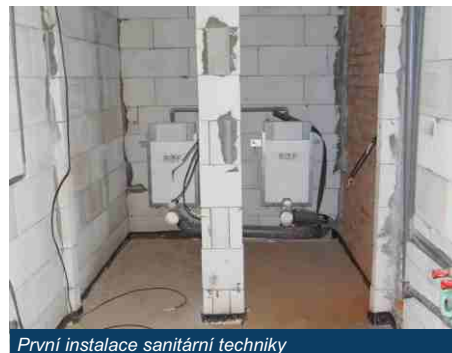
První instalace sanitární techniky
