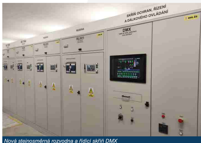
Nová stejnosemnná rozvodna a řídicí skřín DMX
