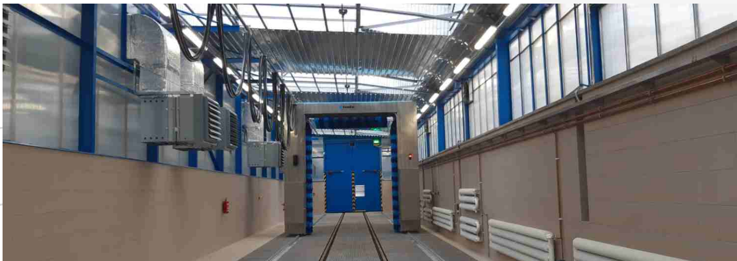
Nová myčka má neprůjezdný mycí portál objíždějící tramvaj
