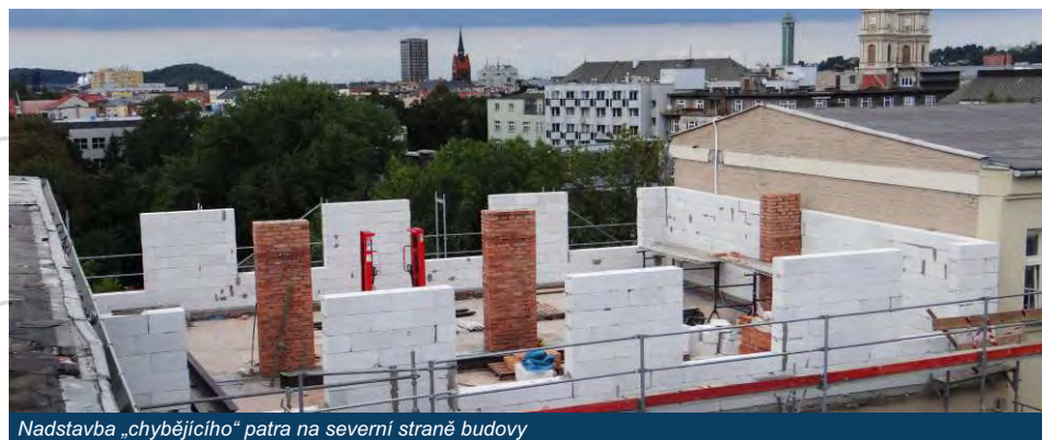
Nadstavba „chybějícího“ patra na severní straně budovy
