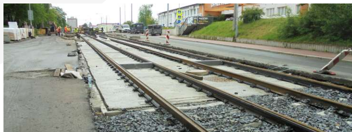
Technicky se jedná o stejnou konstrukci pevné jízdní dráhy jako u zastávky Náměstí Svatopluka Čecha. Nový úsek pevné jízdní dráhy měří 343 metrů
