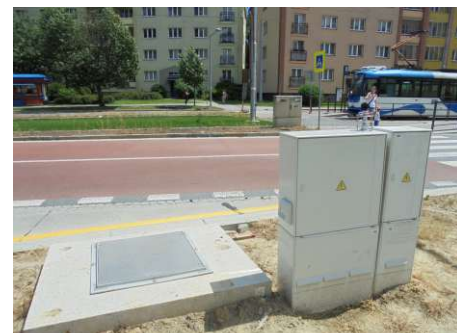
Ovládací elektronika dokáže vyhodnotit vliv srážek a vlhkost půdy a optimalizovat automatické zavlažování
