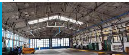
Nový střešní plášt' s robustní vrstvou tepelné izolace v tloušťce 150–280 mm
