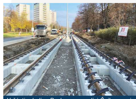
V části od ulice Pavlovovy po ulici Čujkovovu je instalován monolitický železobetonový rošt
