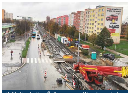
V části od ulice Čujkovova po Kino Luna je konstrukce z prefabrikovaného roštu
